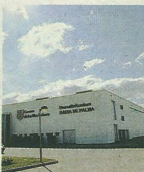
La desaladora de Palma, a punto.
